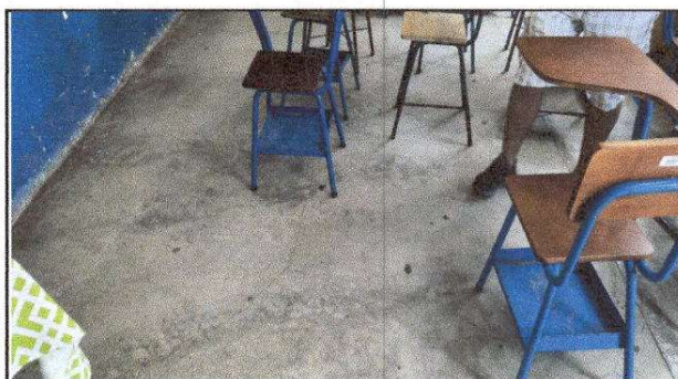
FOTO 4: Sustitución de piso cerámico
