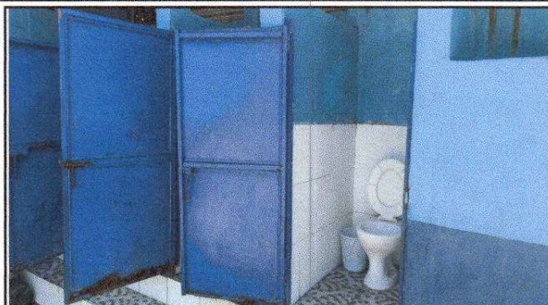
FOTO 2: Fabricación e instalación de puertas de metal en baños
