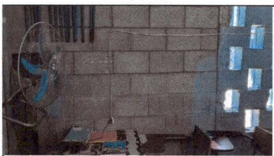
FOTO 11: Repello en muro
