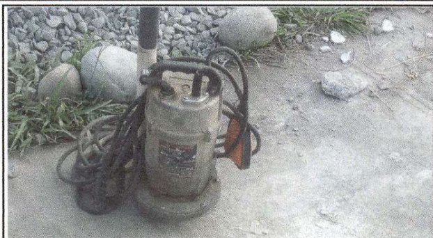
FOTO 1: Sustitución de bomba de agua
